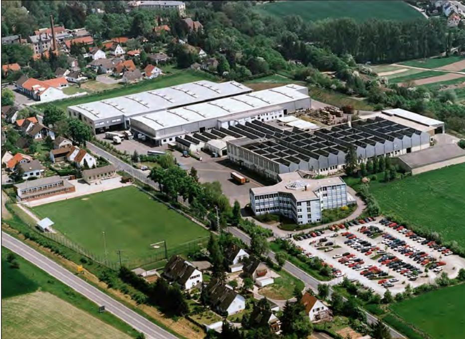
Die BITO-Produktionsanlagen in Meisenheim /Pfalz.
